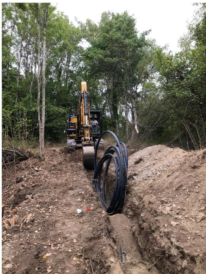
Installation de la nouvelle canalisation vers Touage.
